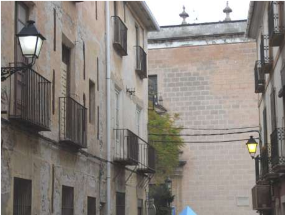
La primera farola de inducció instal·lada en la calle Loreto y su efecto frente al vapor de Sodio (Marzo 2010).
